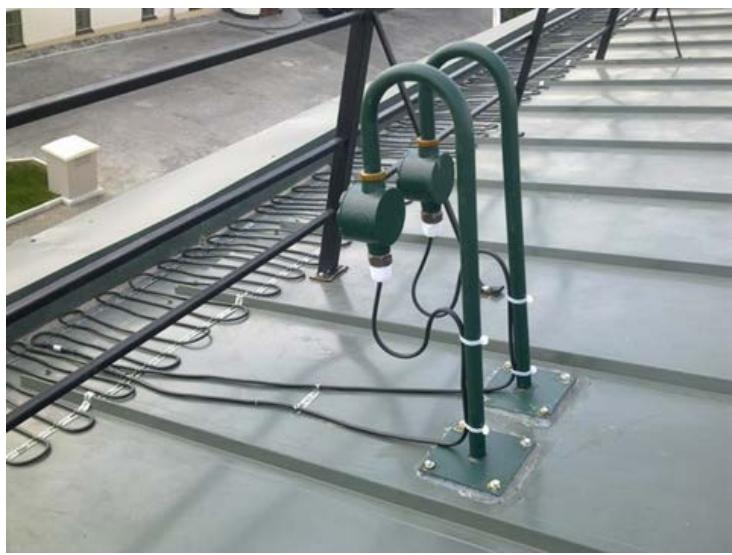
Рис. 3. Монтаж нагревательного кабеля на крыше. ДЕВИ Snow-30Т
