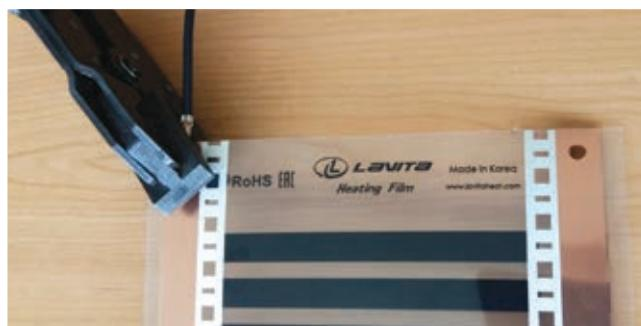
6 Зачистите кабель и вставьте его в наконечник, надежно закрепив при помощи инструмента для обжима.
