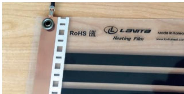
5 Закрепите наконечник люверсом с помощью специального инструмента.
