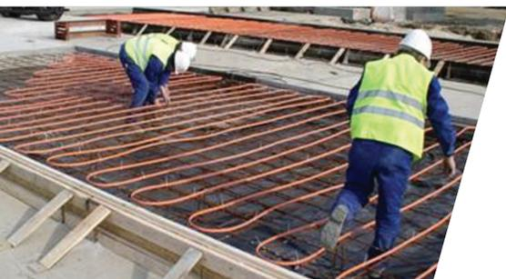
**Расход кабеля составляет 4 п. м. на 1 м<sup>2</sup> прогреваемой поверхности\***
